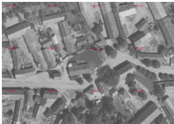
Na ortofotomapě z roku 1946 je vidět kapli, na ni navazující budovu původního obecního domu a hasičskou zbrojnici. [4]
