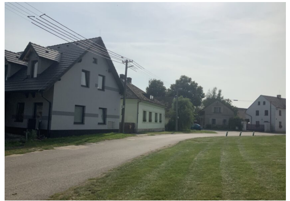
novostavba v místě původní zástavby
